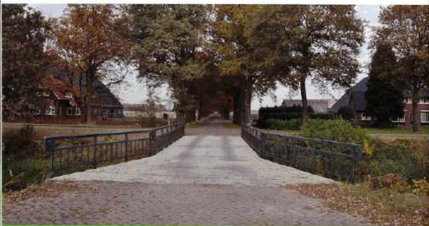
De Middenraai eindigt in het Westerborkerveld, een kilometer ten noorden van de dorpskom. Hier ligt ruim 2000 meter kanaal haaks op de Middenraai. Over deze 'zijtak' ligt nog een originele brug zoals er in Witteveen een paar meer hebben gelegen. De brug was een schakel in de verbinding van Orvelte naar
